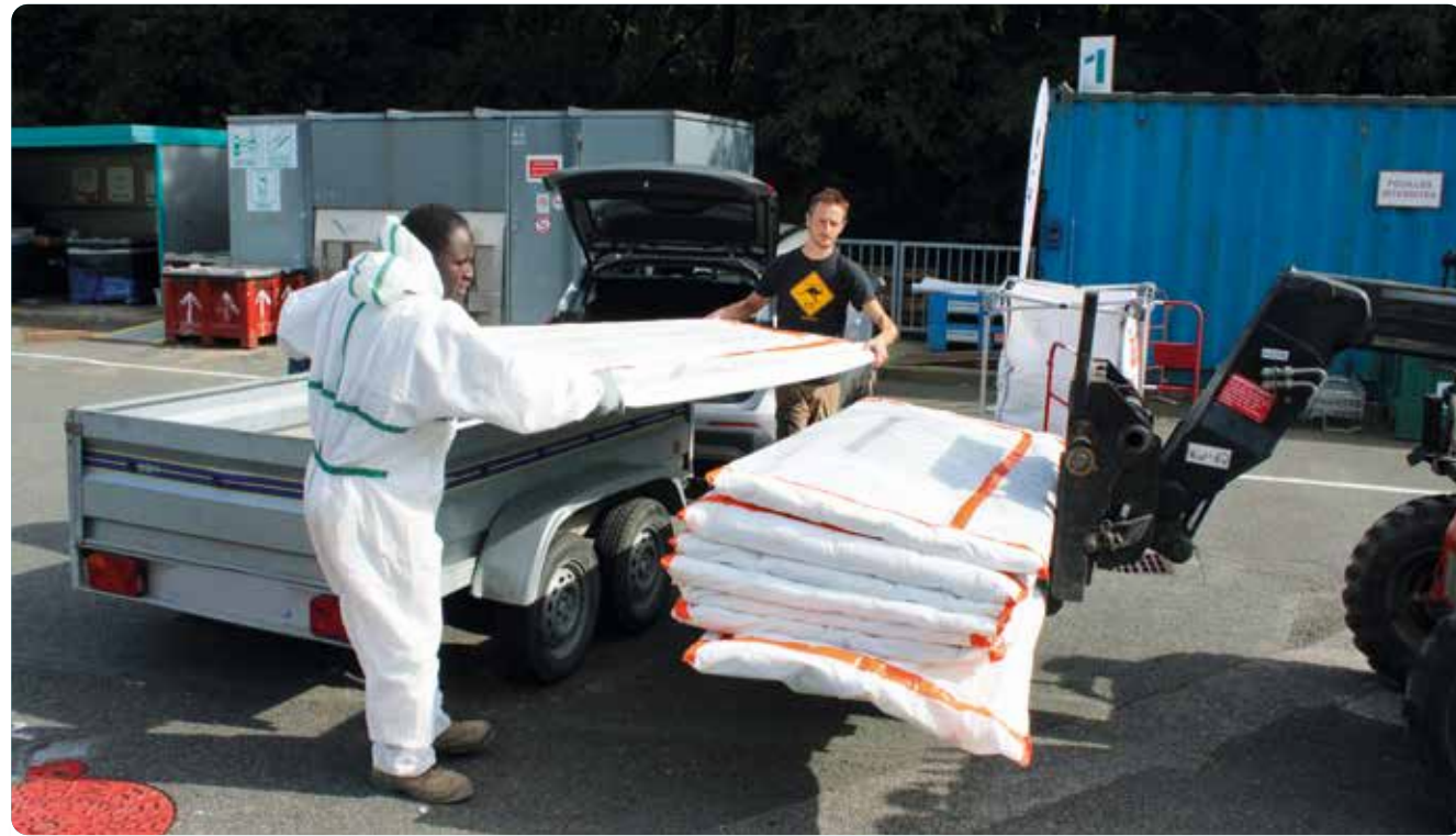
Un usager et le prestataire spécialisé déchargent les déchets d'amiante lié.
