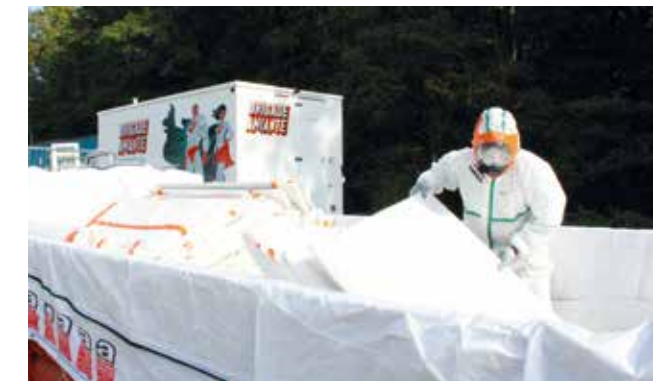
Le prestataire spécialisé dans la collecte et le traitement de l'amiante manipule les déchets.
