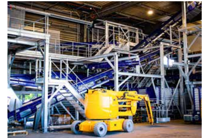
Installation des machines dans le nouveau centre de tri.
